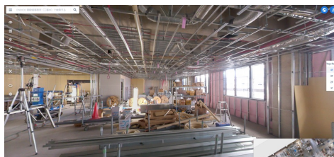
施工途中段階での記録状況（配線・配管等）
